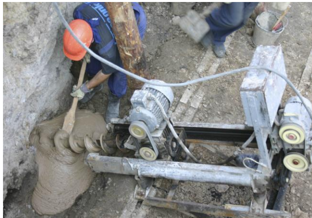
Рис. 2. Видалення водонасиченого ґрунту з-під фундаменту вибурюванням з лідерних свердловин
