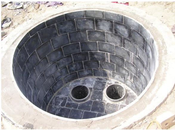
Рис. 1. Футерування базальтовими плитами каналізаційної шахти
